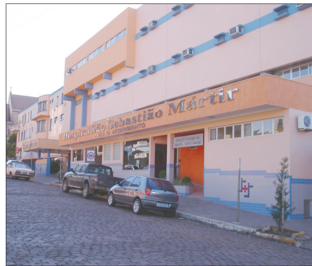
Fachada atual do Hospital São Sebastião Mártir
