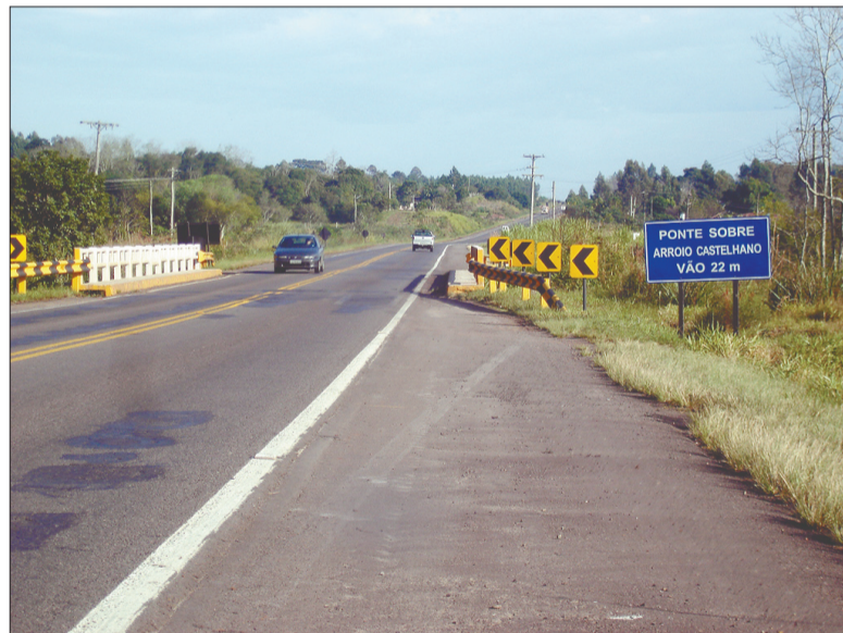
Ponte da RSC-287 sobre a Sanga da Divisa. A informação da placa está incorreta
