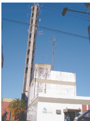
Prédio da Brasil Telecom. Ao fundo a torre de telefonia celular
