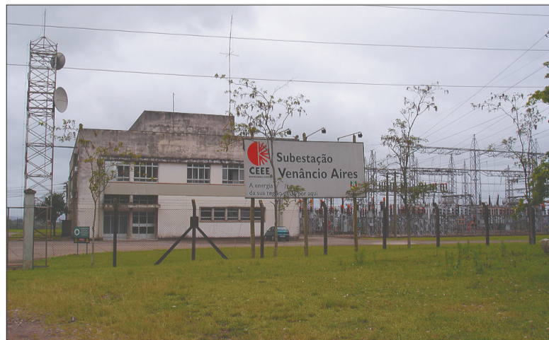
Subestação da CEEE recebe energia elétrica da barragem de Salto do Jacuí
