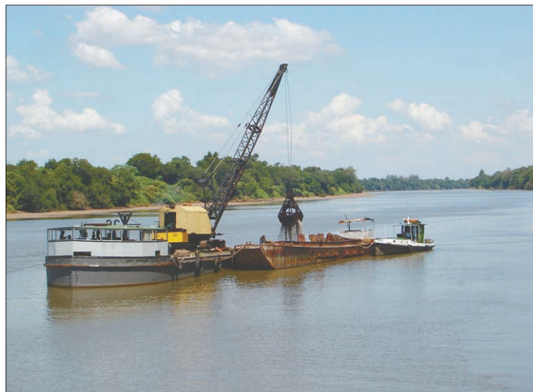
Periodicamente, canal do rio é dragado para retirada de cascalhos e entulhos
