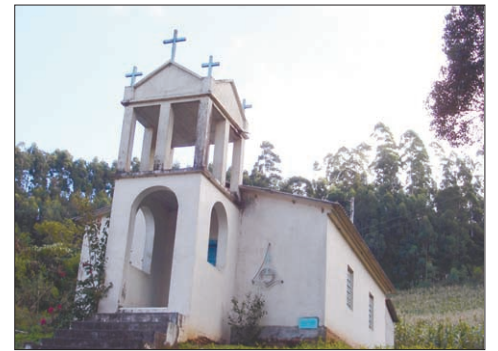
Igreja evangélica Martin Luther, construída em 1981
