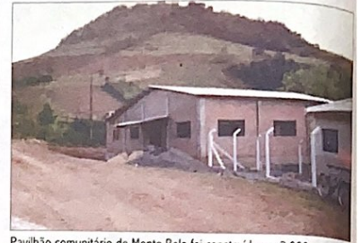
Pavilhão comunitário de Monte Belo foi construído em 2000
