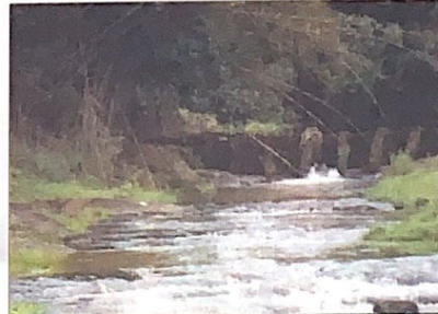
Antiga barragem no arroio Lajeado, em Linha 17 de Junho
