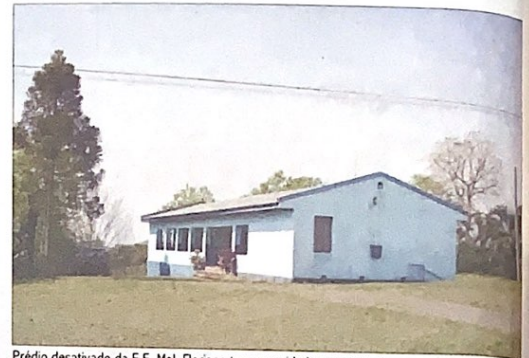
Prédio desativado da E.E. Mal. Floriano tem capacidade para 100 alunos
