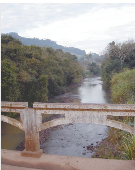
O leito pedregoso do arroio Sampaio na Vila Teresinha
