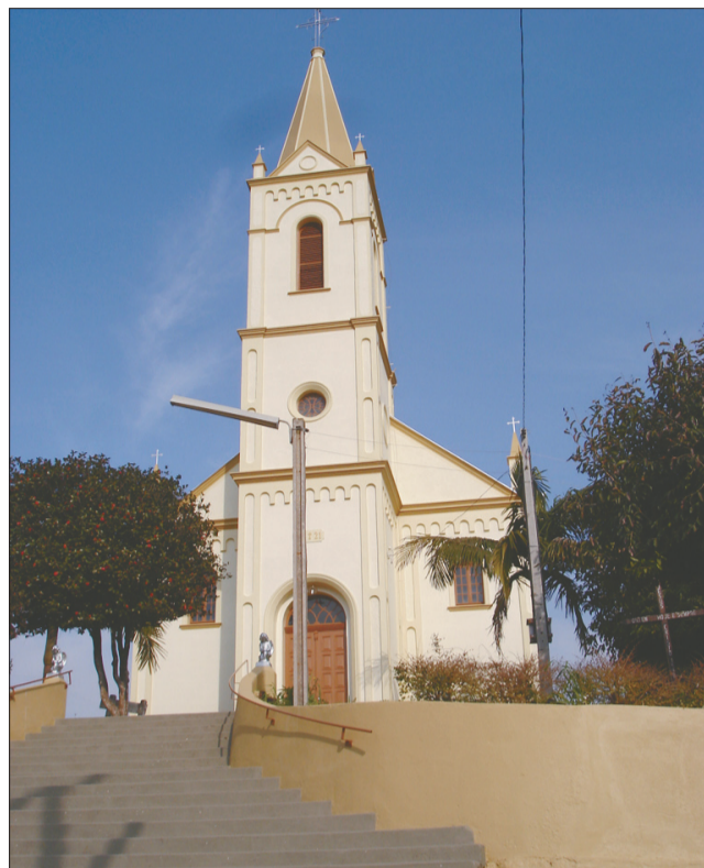
Capela São Miguel, construída em 1921 e restaurada em 2007
